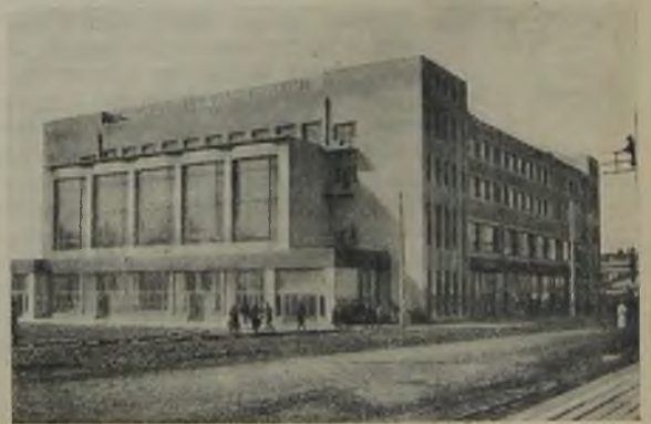
Здание „Доходного дома“ Горкомхоза. (Ново-Сибирск).
