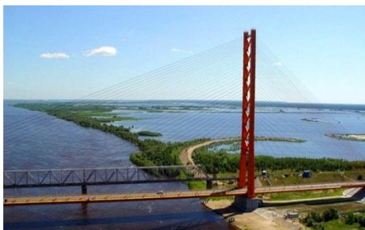
Генеральным подрядчиком выступил трест АО «Мостострой-11». Сургутский мост – первый вантовый мост в азиатской части России. Его протяженность – 2 110 м, ширина – 15,2 м, длина вантового пролета – 408 м, высота пилона превышает 160 м.
